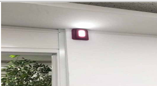
시각경보장치 설치
