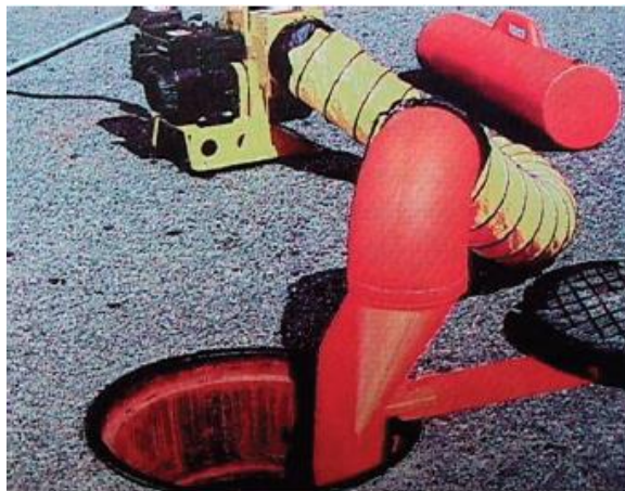
맨홀의 새들덕트를 이용한 환기방법
